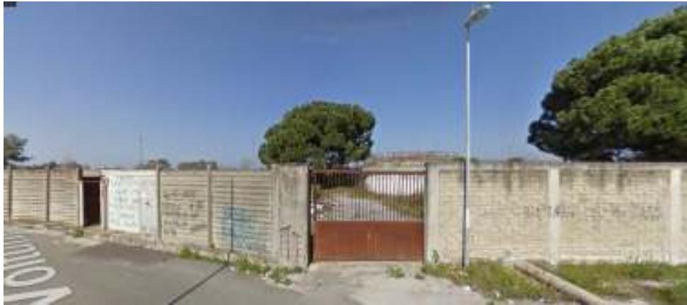
2 Area depuratore dismesso
