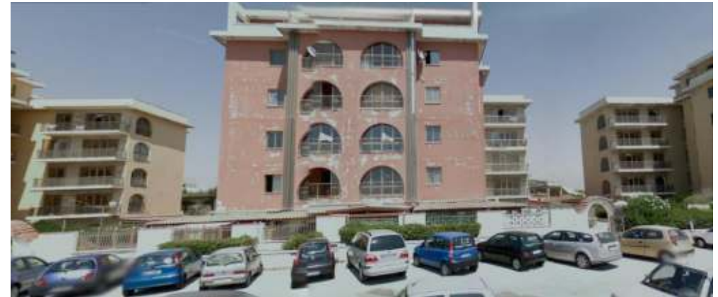
9 Edifici fatiscenti lungomare Pinetamare
