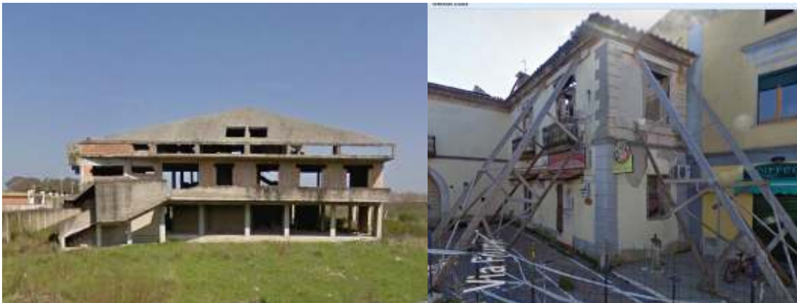
3 Edifici dismessi, incompiuti e pericolanti
